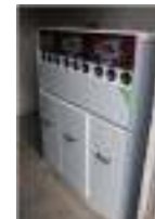
Stikalni bloki RM6 (tudi polnjeni s SF 6 ), SCHNEIDER (Merlin Gerin).
